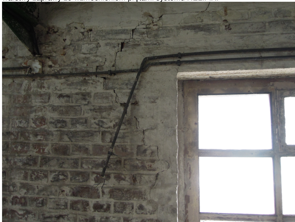
Zarysowanie w strefie podporowej nadproża stalowego.
