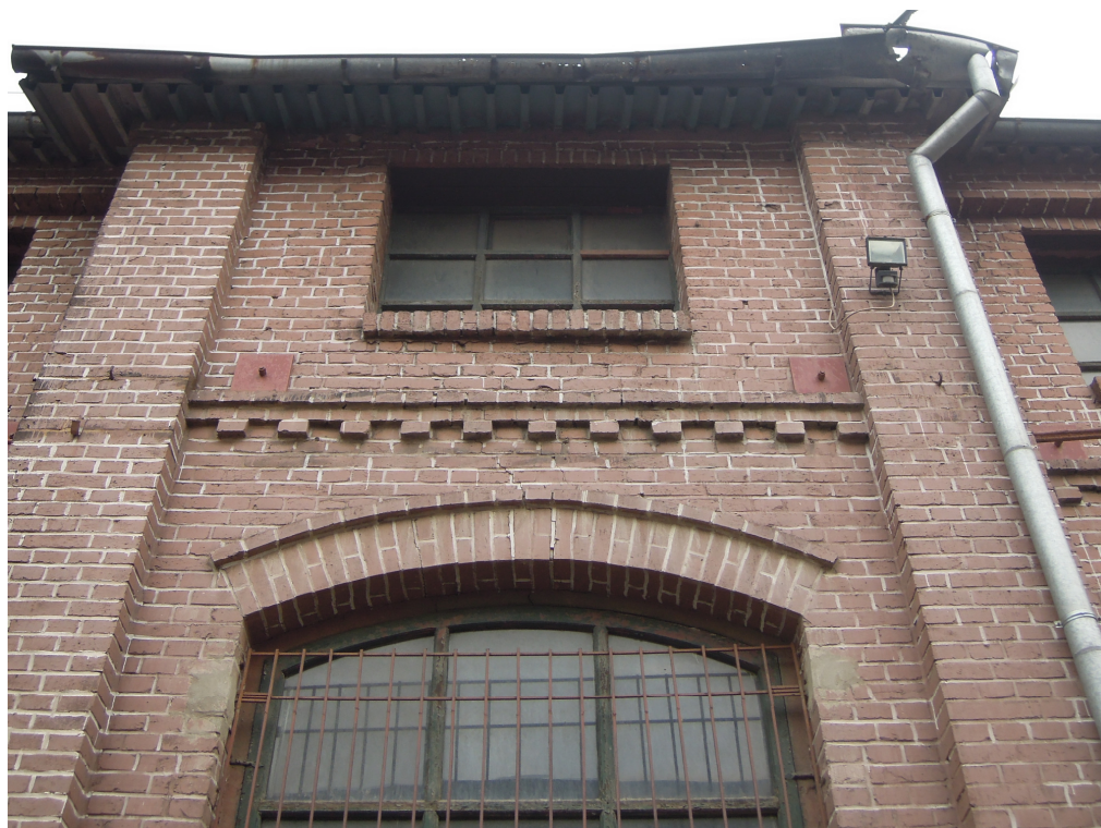
Zarysowanie nadproża ceglanego oraz pasa międzyokiennego.
